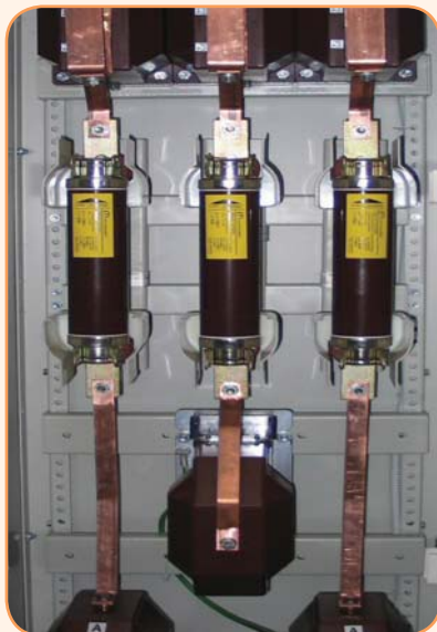
Внутренняя установка предохранителей
