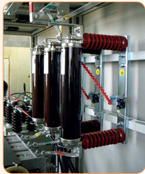
Установка внутренних держателей предохранителей*
